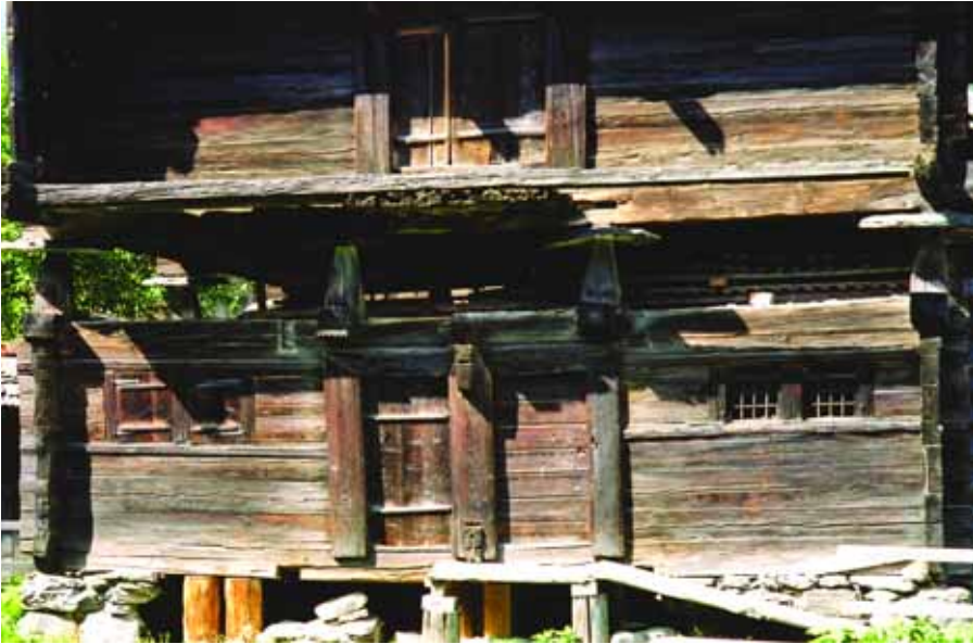
Dem wackeligen Fundament zum Trotz – der Reckinger Stadel 1617 wendet noch immer selbstbewusst das heitere Gesicht seiner mit Rillenfriesen geschmückten Südfassade dem Betrachter zu.
