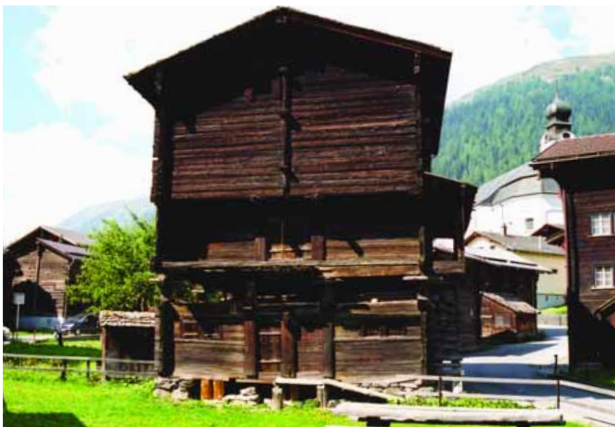
Die außergewöhnliche Wirkung des Stadels 1617 beruht nicht allein auf seiner architektonisch durchgebildeten Gestalt, sondern vor allem auf seiner einzigartigen Stellung mitten im Ortsbild.
